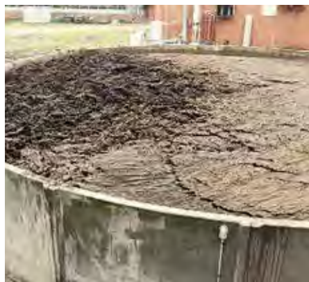
Hohe TS-Gehalte im Substrat können zu dicken Schwimmschichten führen.
